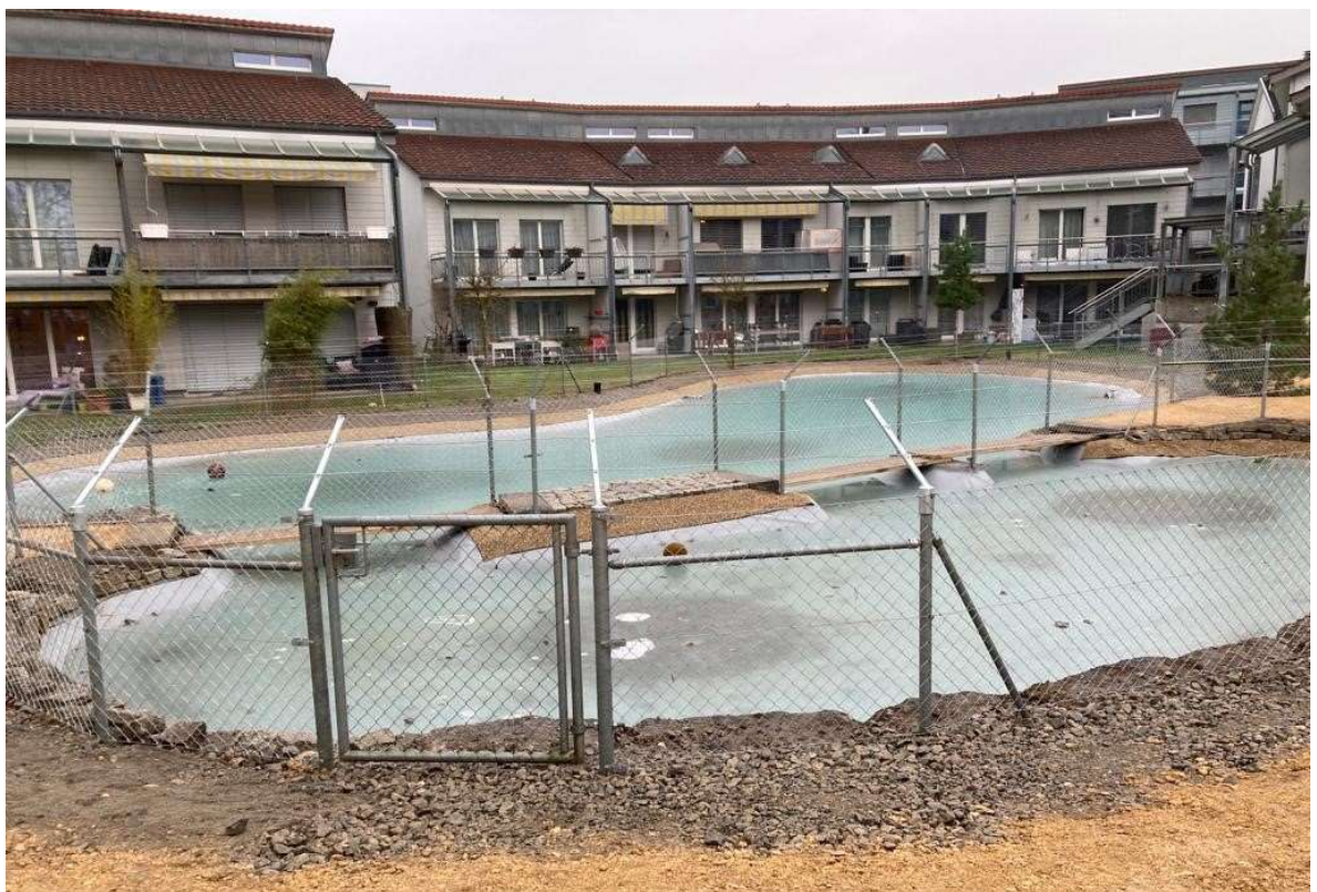
Teich Zelgmatte nach Sanierung
