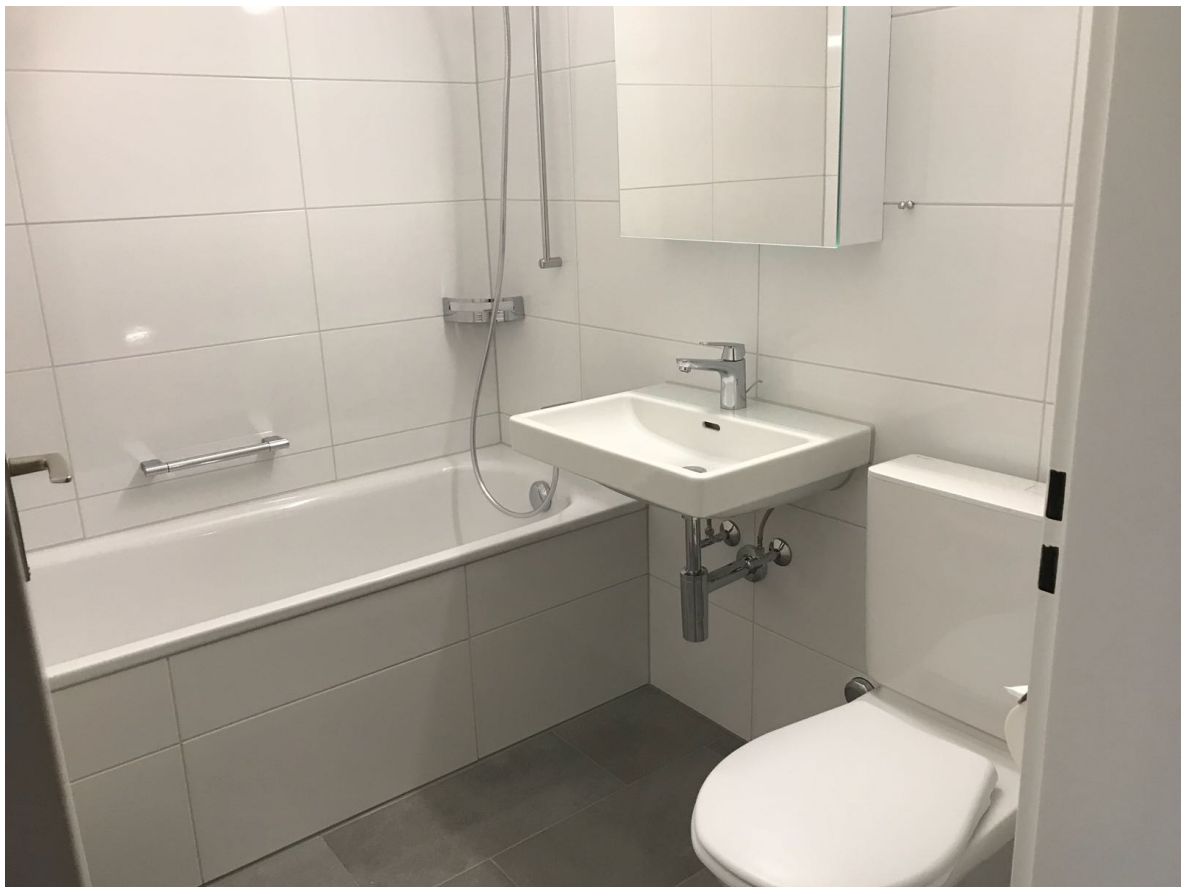
Neues Badezimmer nach Sanierung FL 5
